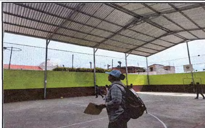
Foto 1: Finalización de mejoramiento de techo.
