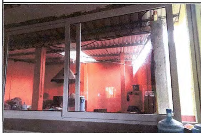
Foto 3: Finalización de mejoramiento de ventanas.
