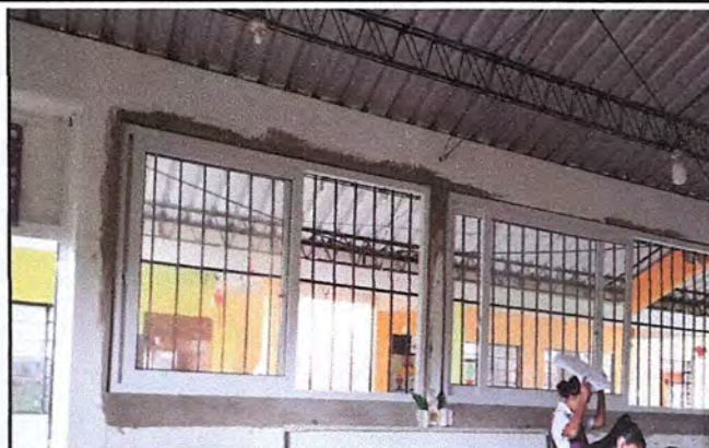
Foto 2: Finalización de mejoramiento de ventanas.
